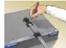
4. Trasferire le misure sul pannello isolante
